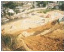
造成中のグラウンド
